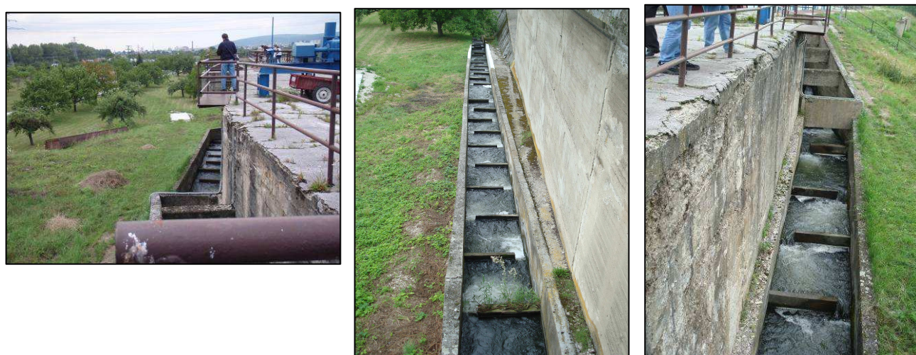
Obr.č.4.4i Vybraná fotografická dokumentácia z VE Nové Mesto nad Váhom - rybovod
