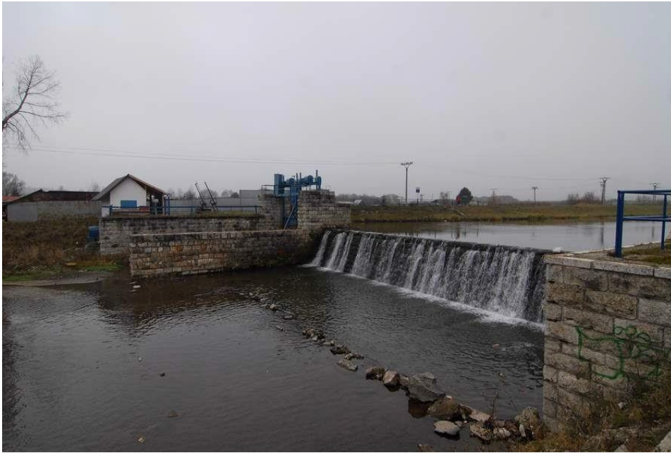
Obr. 5.4. Neprekonateľná bariéra a ďalšie výrazné hydromorfologické úpravy (pozri text pri obr. 5.1) na rieke Poprad v úseku medzi Svitom a Popradom, ktorý by podľa ukazovateľa EFI mať byť v najkvalitnejšej kategórii ekologického stavu podľa rýb a mohol by tak dokonca predstavovať etalón pre ostatné vodné toky na Slovensku.
