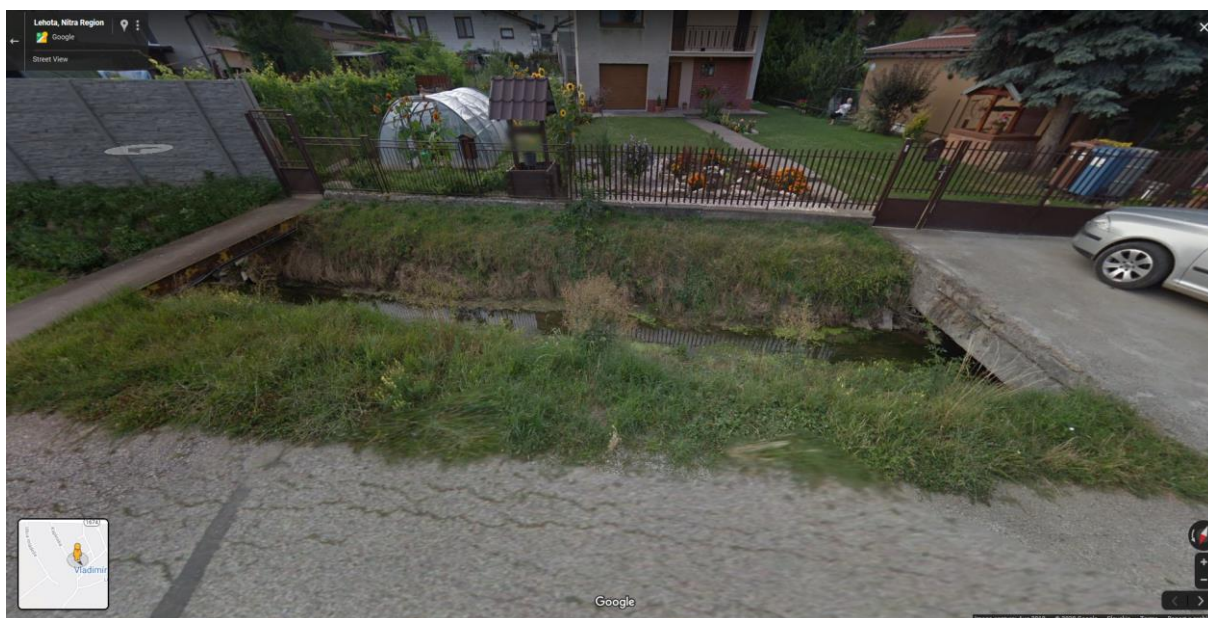
Obr. 54 SKN0020 – Dlhý kanál, v blízkosti MO-PzV č. SKV216409 - Lehota
