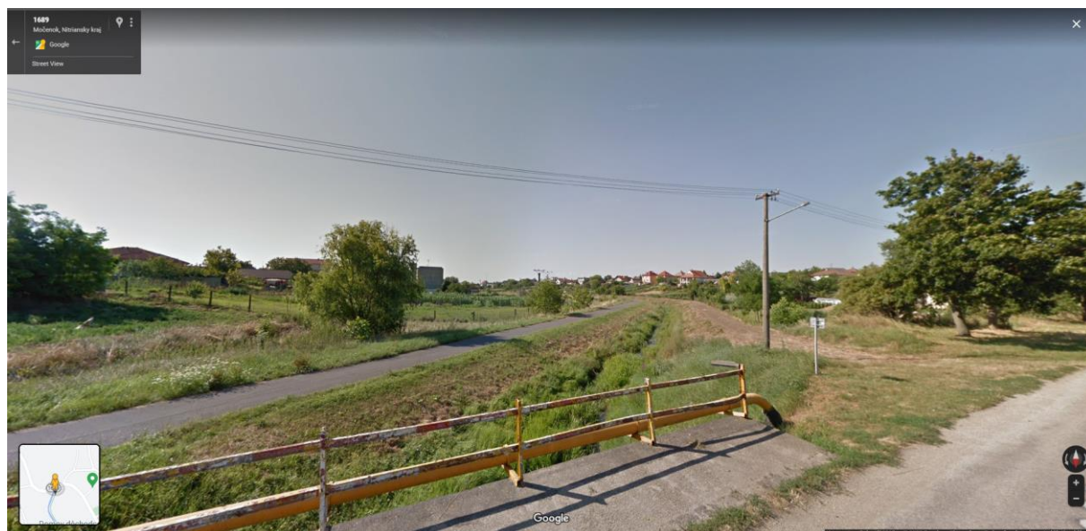
Obr. 55 SKN0020 – Dlhý kanál v blízkosti MO-PzV Horná Kráľová (2019- Google Street View ©2020 Google)
