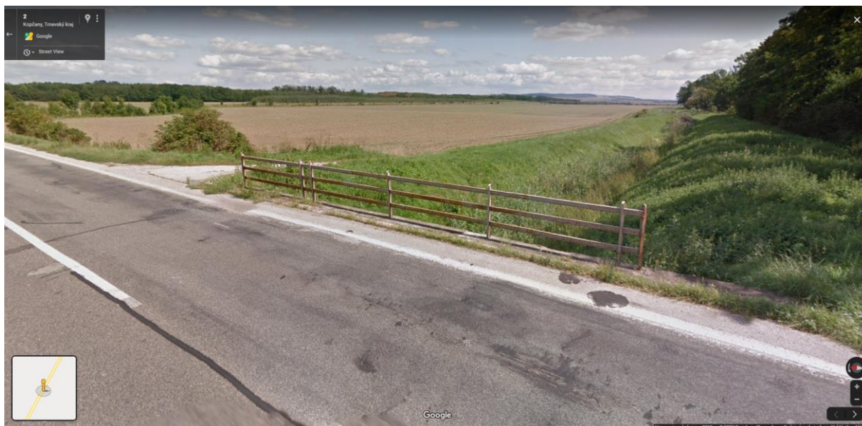
Obr. 75 SKM0040 – Unínsky potok v blízkosti MM-PV Adamov Kopčany (2019- Google Street View ©2020 Google)
